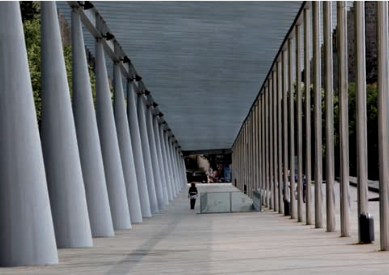
Pasarela da avenida de Xoán XXIII - Pasarela de la avenida de Xoán XXIII - Avenida Xoán XXIII Walkway
