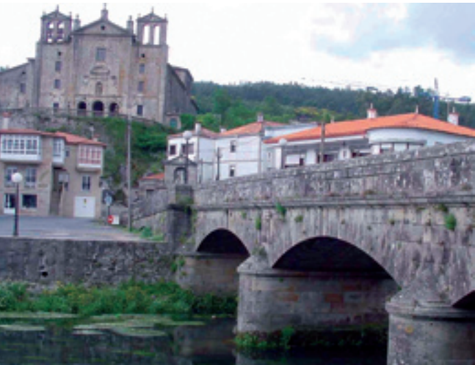
El Puente de Santiago y el Convento del Carmen.
